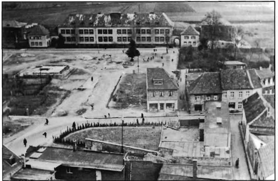
Auf der Plektrudisstraße, dem Wickrather Tor und an der Schule war das einzige Gebäude, das nach dem Bombenangriff 1945 noch einigermaßen unbeschädigt aussah, die Schule.
